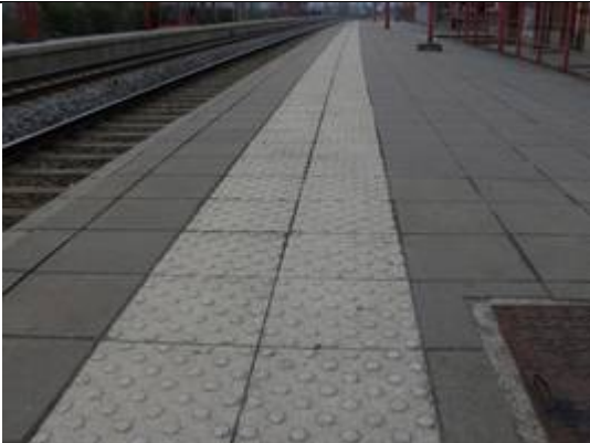
Revêtement des quais
