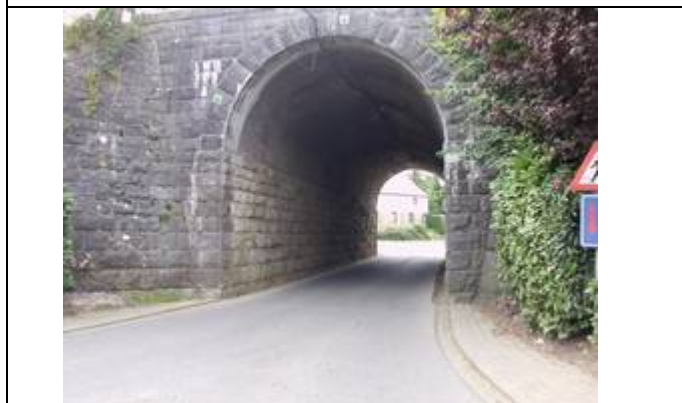
Pont sous les voies
