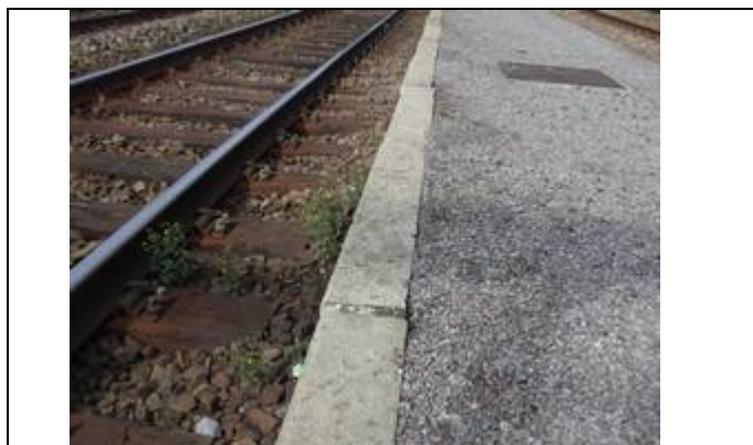
Revêtement des quais
