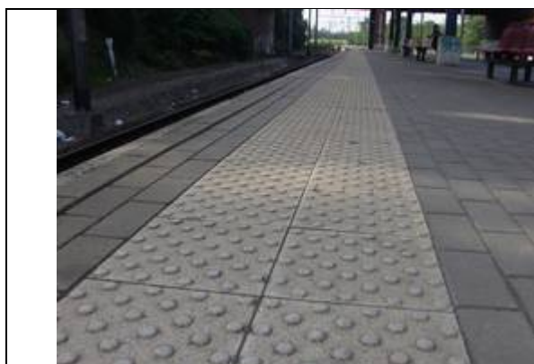
Revêtement des quais
