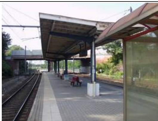
Quai partiellement couvert
