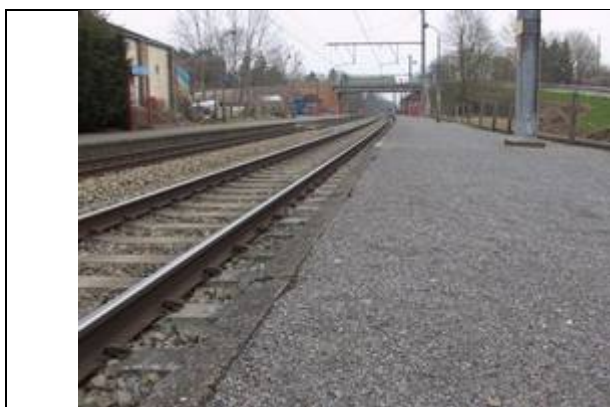
Revêtement des quais
