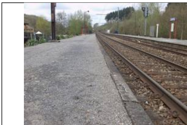
Revêtement des quais
