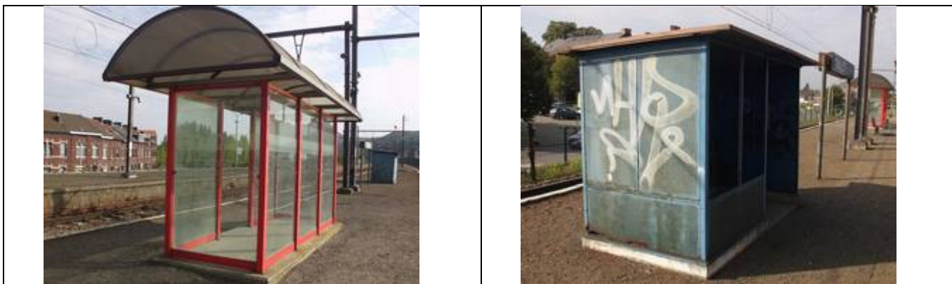
Abris sur les quais
