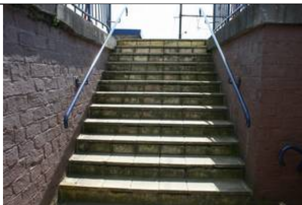
Escaliers d'accès au couloir sous-voies
