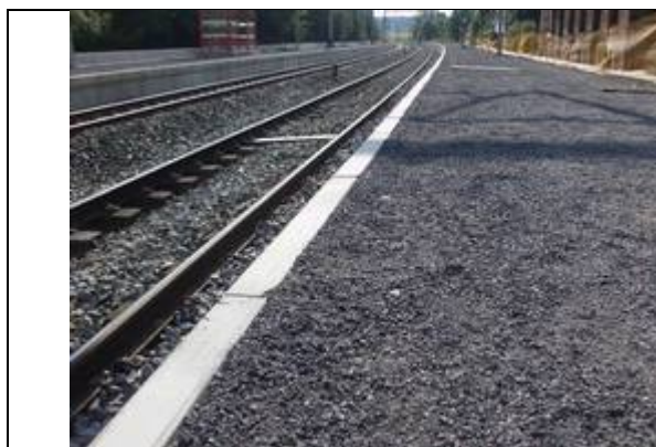
Revêtement des quais
