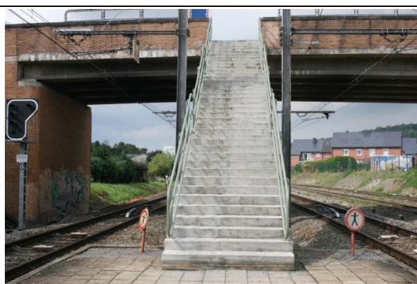
Escaliers d'accès aux quais
