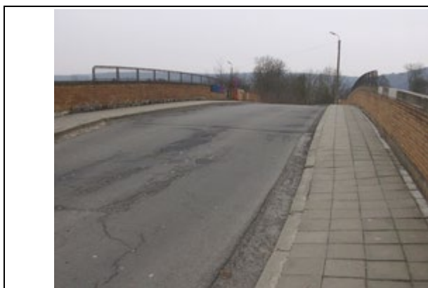
Pont au-dessus des voies
