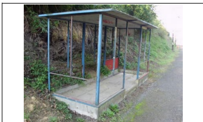
Abris sur les quais
