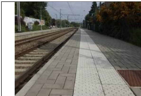
Revêtement des quais
