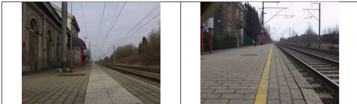
Revêtement des quais
