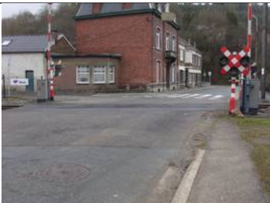
Passage à niveau
