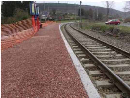
Revêtement du quai
