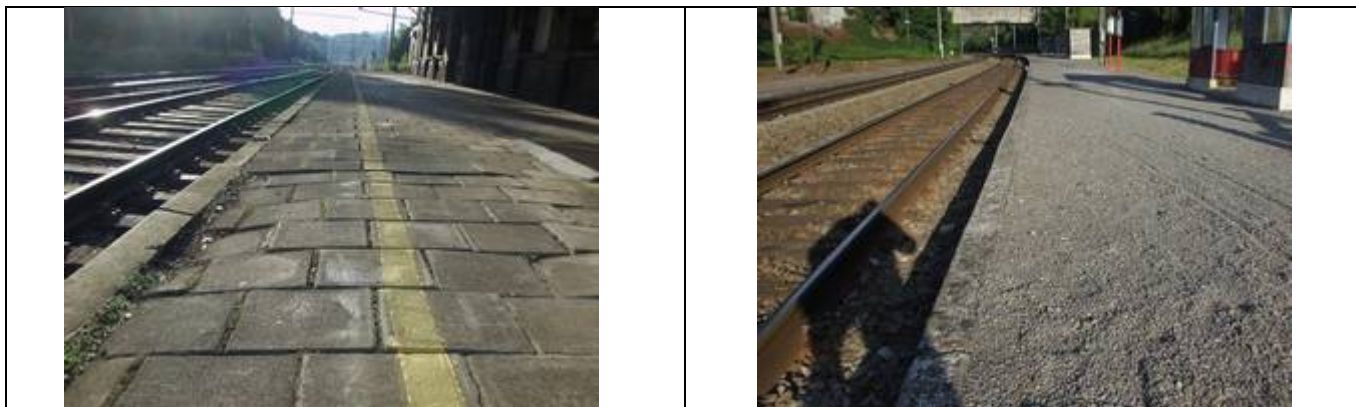
Revêtement des quais
