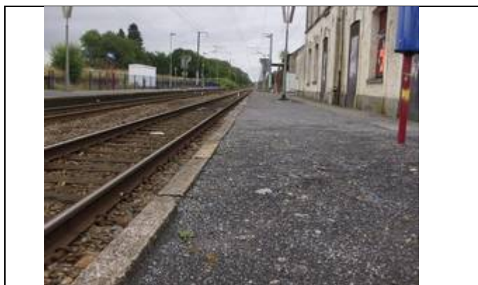
Revêtement des quais
