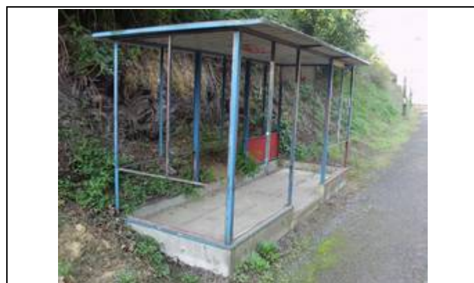
Abris sur les quais
