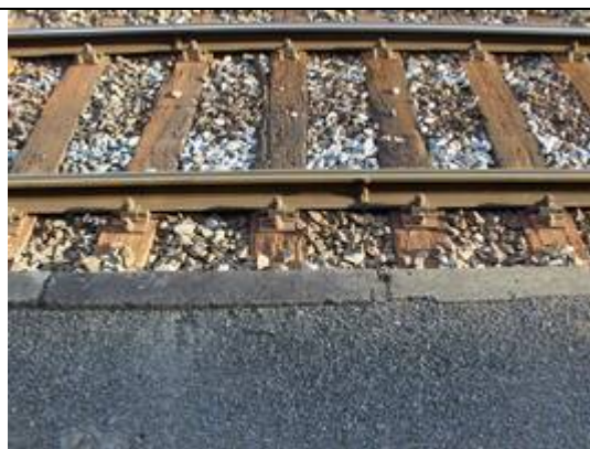
Absence de dalles podotactiles
