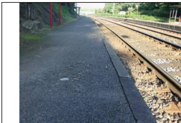
Revêtement des quais
