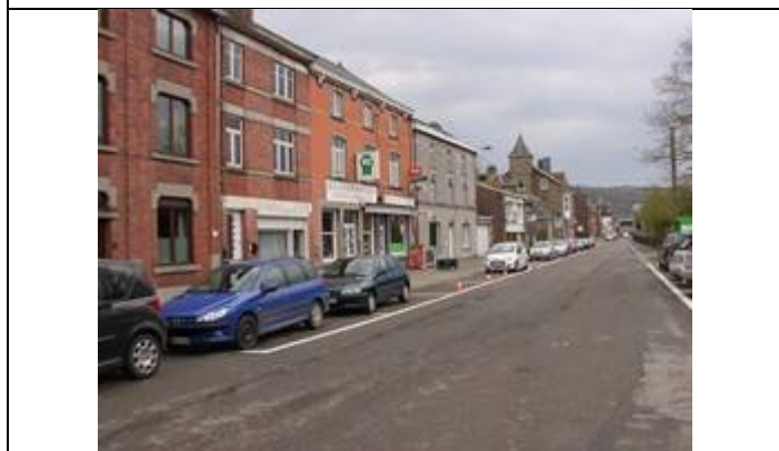
Stationnement en voirie
