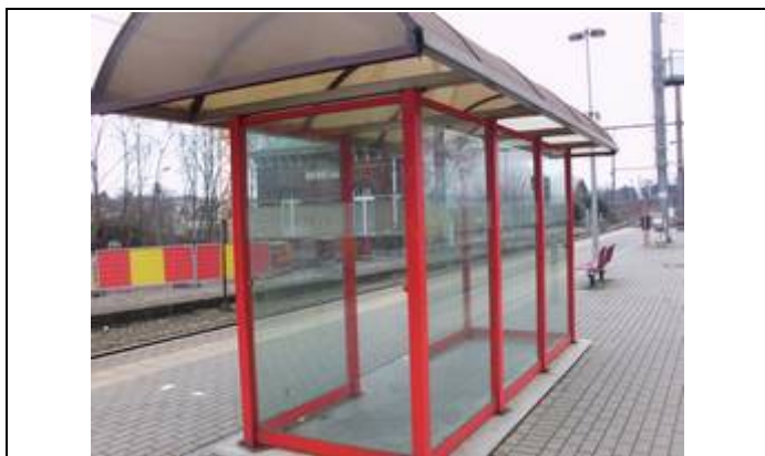
Abris sur les quais
