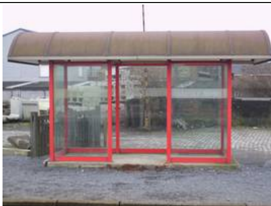
Abris sur les quais
