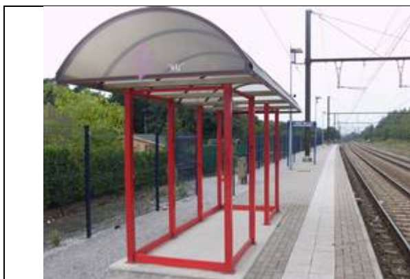
Abris sur les quais
