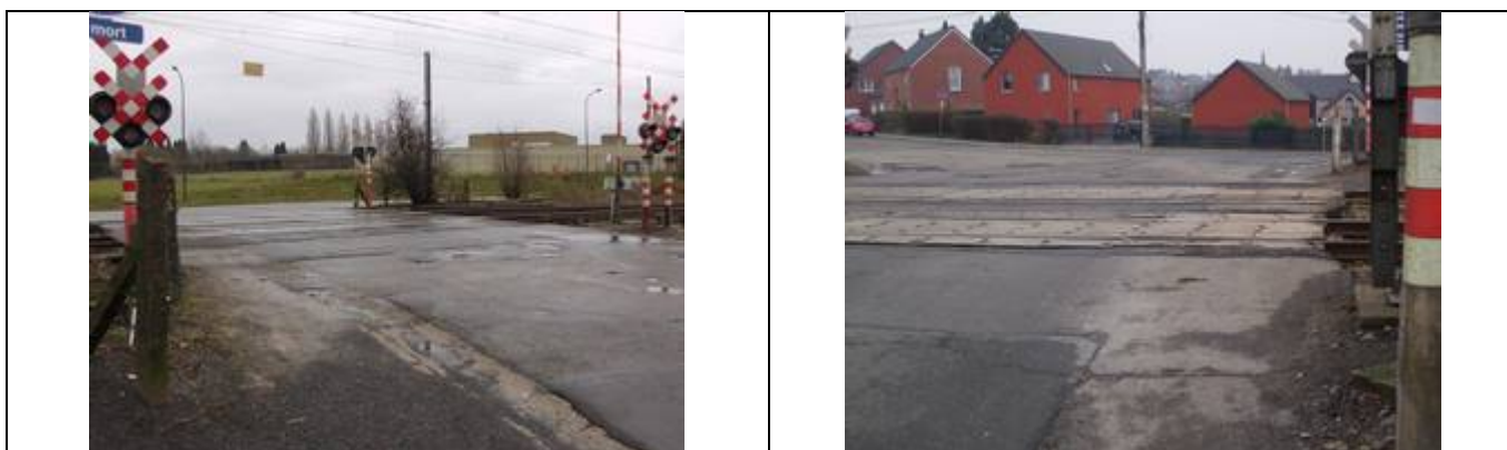
Passage à niveau
