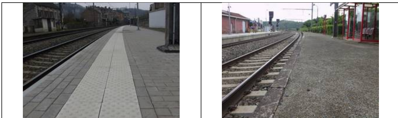
Revêtement des quais
