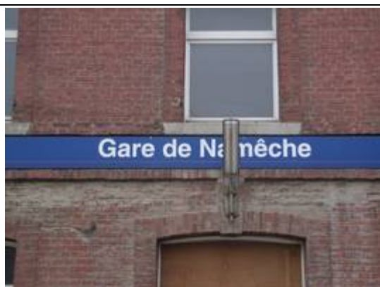
Panneau sur le bâtiment
