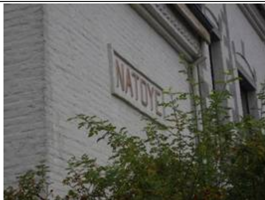
Panneaux sur le bâtiment
