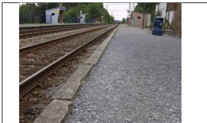
Revêtement des quais
