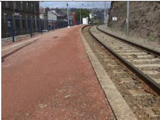
Revêtement du quai
