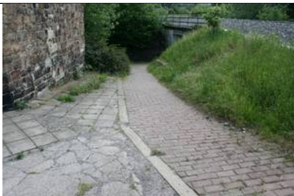
Rampe d'accès au couloir sous-voies
