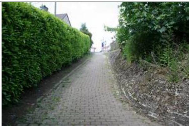
Rampe d'accès au couloir sous-voies
