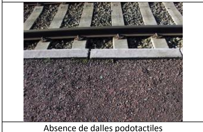
Revêtement des quais
